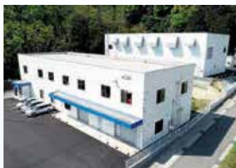
西湘テクニカルセンター
