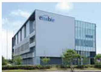
神戸テクニカルセンター
